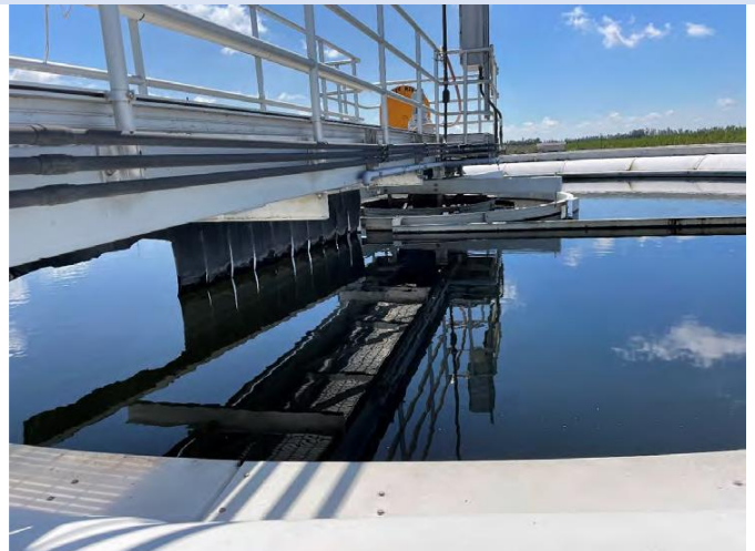
La planta de tratamiento de aguas del drenaje y el proyecto de agua reciclada harán que el suministro de agua de la Ciudad sea más limpio y seguro durante décadas.
