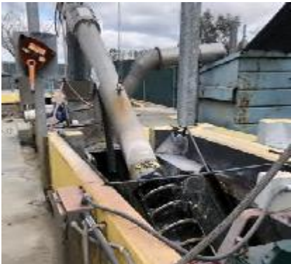
La planta de tratamiento de aguas de drenaje existente ha servido a la Ciudad desde 1963.
